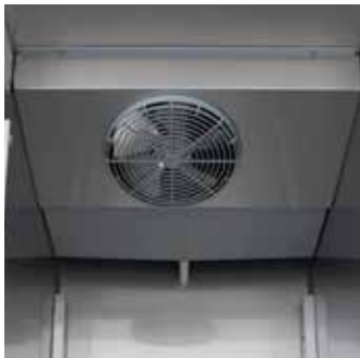
Крышка испарителя из нержавеющей стали
