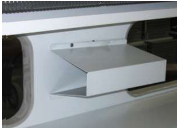
Рис. 3. Положение опоры желоба в состоянии поставки витрины
