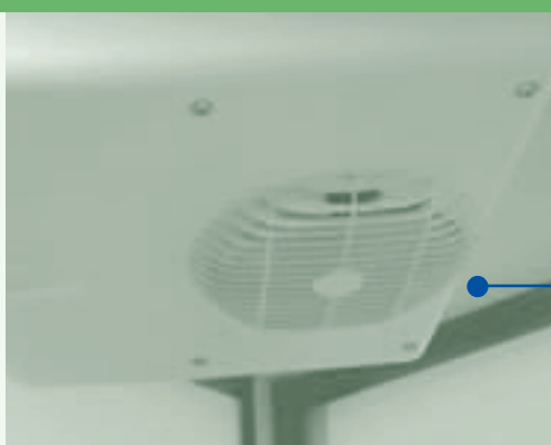
Динамическое охлаждение - воздухоохладитель с тэном оттайки
