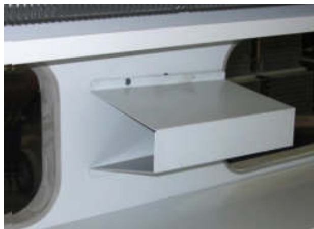
Рис. 3. Положение опоры желоба в состоянии поставки витрины
